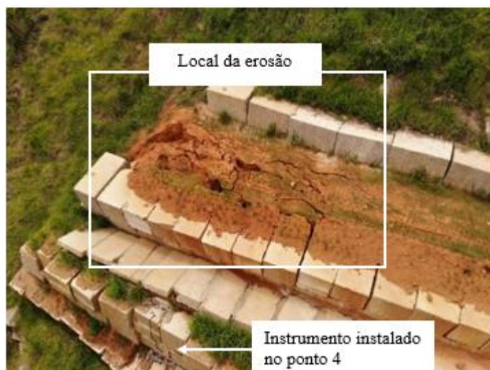
Figura 14. Identificação da erosão próximo ao ponto 4.
